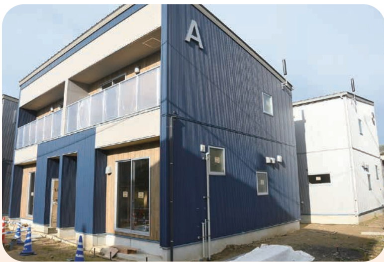
▲建設中の子育て世帯向け城南住宅
