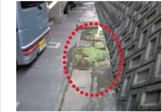
水がしみだしている擁壁 湧水部分にコケが生えている擁壁 (提供：社団法人 全国宅地擁壁技術協会)
