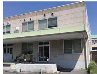
◀給食センター(外観)
