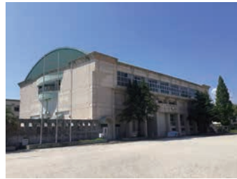
▲屋内運動場(外観)
