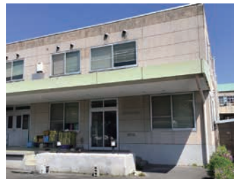
◀給食センター(外観)
