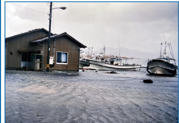
2004年(平成16年)8月30日撮影 台風第16号(尾津東)
