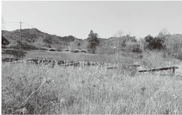
太陽光発電所
