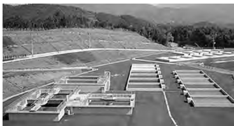
柳井地域広域水道企業団浄水場
