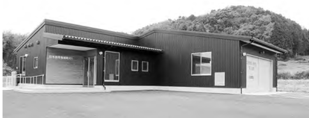
田布施南地域防災センター
