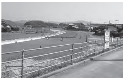
工事中の瀬戸バイパス
