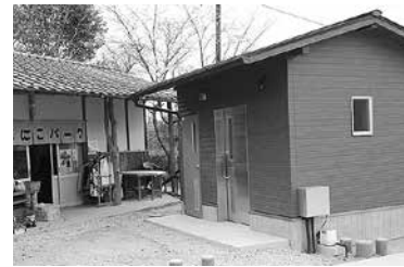
新設されたトイレ
