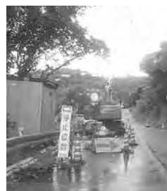
進む復旧工事（宿井）
