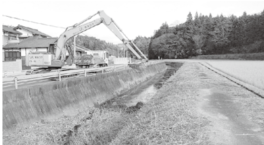
堆積土砂の撤去（丸尾川）
