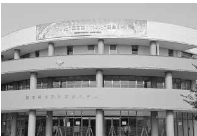
改修が終わった中学校
