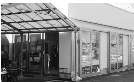
リニューアルオープンした地域交流館
