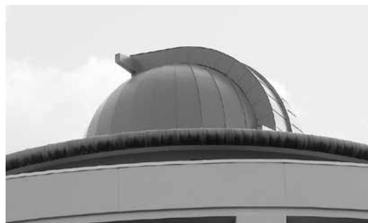
外装が綺麗になった天体ドーム
