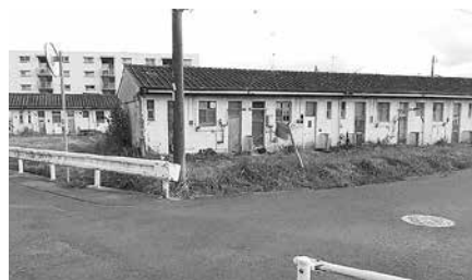
解体予定の波野北住宅
