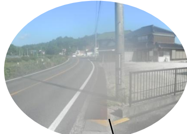
歩道内自転車乗り入れあり 車道に降りると危ない
