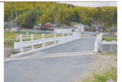
平成26年度に整備された松尾橋
