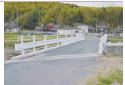
平成26年度に整備された松尾橋
