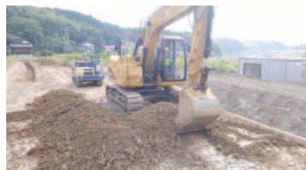
▲表土除去状況
