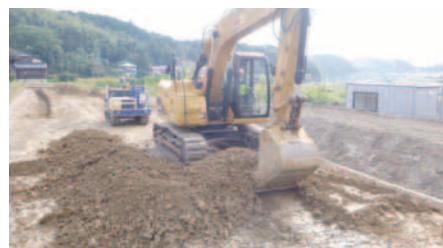
▲表土除去状況
