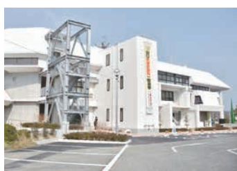
◀ 庁舎耐震改修等事業
