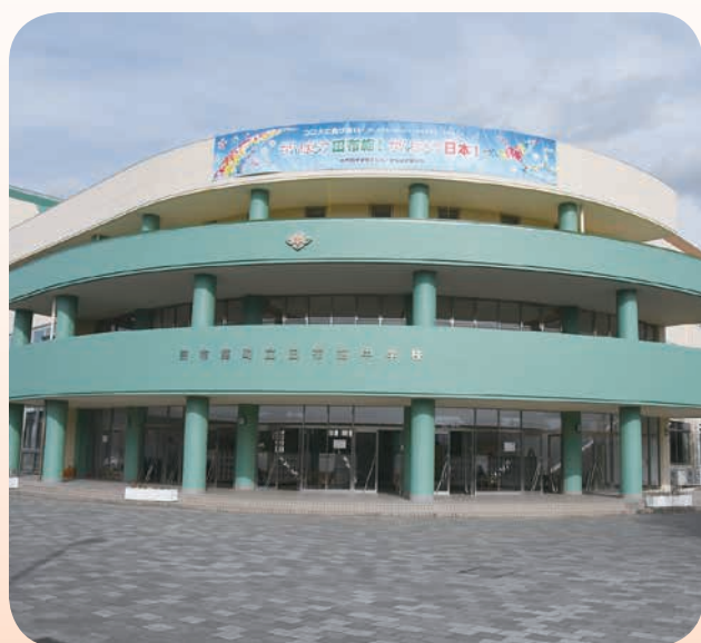
大規模改修により綺麗になった 田布施中学校
