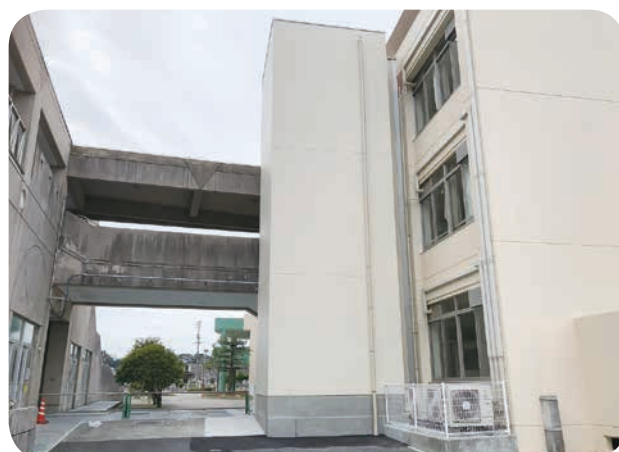
▲完成したエレベーター棟
