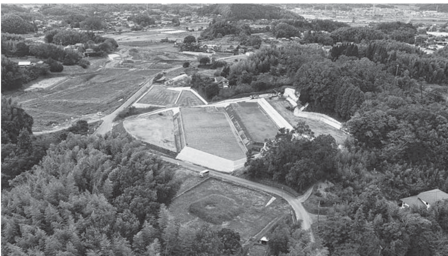
ほ場整備事業（区画整理後の麻郷奥団地）
