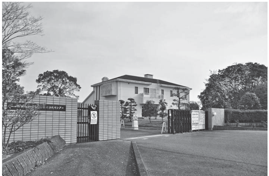
田布施川流域下水道浄化センター（米出）
