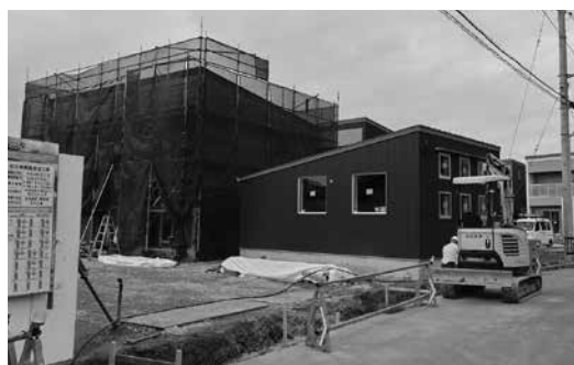
建設中の城南住宅
