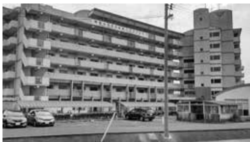
町営波野団地住宅
