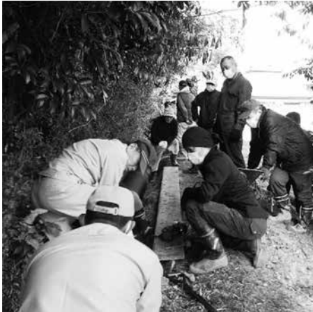
地区総出で水路の改修を行った(大波野地区)
