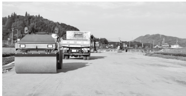
工事中の瀬戸バイパス
