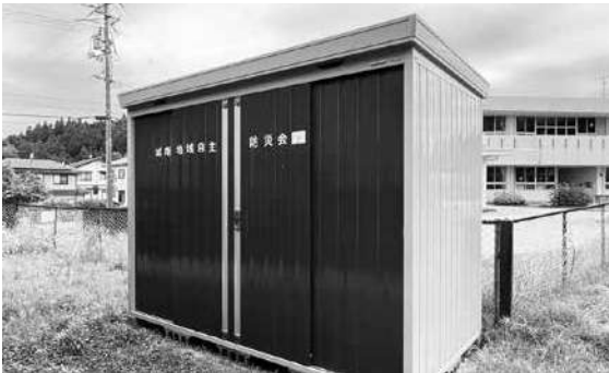
城南地域自主防災会 機材保管庫(城南小学校)
