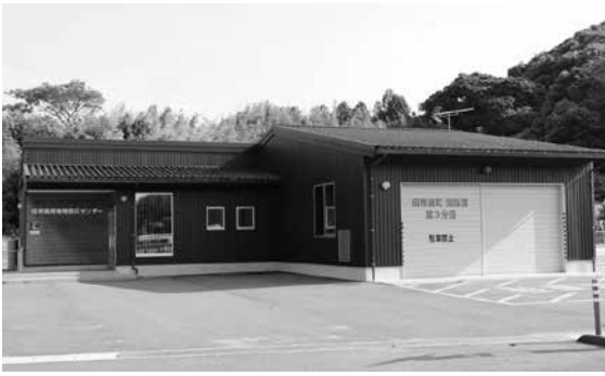
田布施南地域防災センター(浜城)
