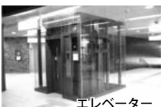
エレベーター
