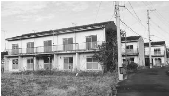
建替予定の城南住宅
