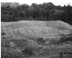
残土処理場の様子
