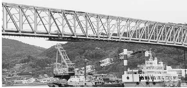
大島大橋の修復工事
