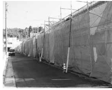
工事中の麻郷団地住宅
