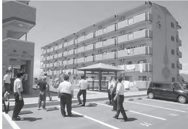
PFI方式で建設された町営住宅(みやき町)
