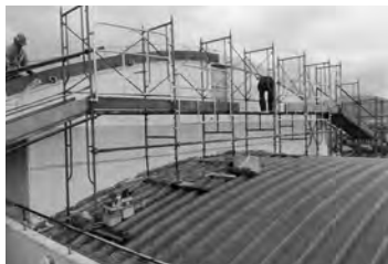
波野団地外壁塗装改修工事の様子 (平成22年)
