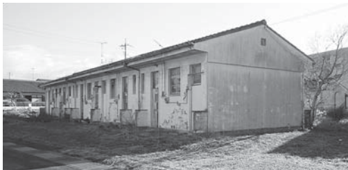
波野北住宅建設予定地
