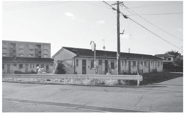
建替測量設計費が計上された波野北住宅
