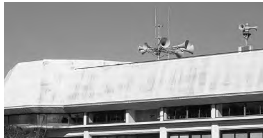
役場屋上の防災行政無線
