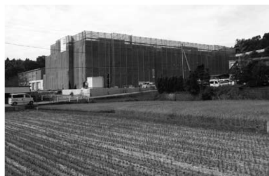
建設が進む麻郷小学校
