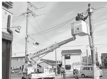
歩車分離式信号への取替工事 (砂田交差点)
