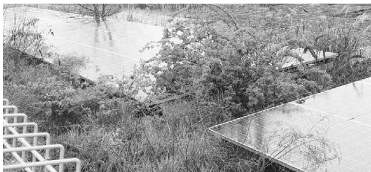
管理されていない太陽光パネル
