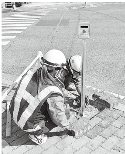
歩行者用押ボタン設置工事
