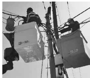
光ファイバー網整備工事
