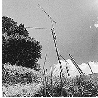
難視聴対策工事
