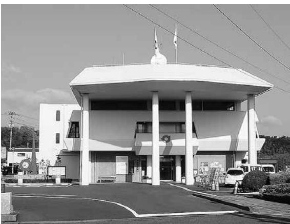
耐震工事を終えた庁舎
