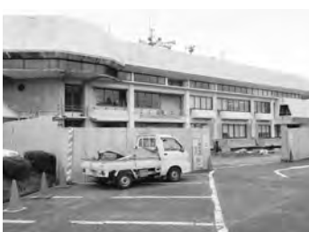
耐震工事中的の本庁舎
