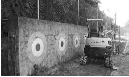
撤去されたブロック塀(城南小学校)
