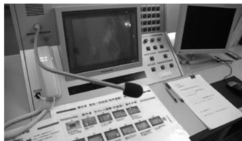
デジタル化した防災無線親機
