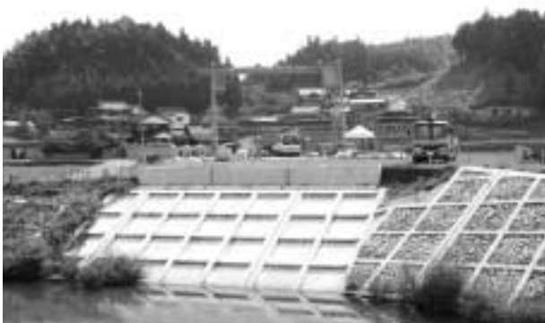
布奈橋災害復旧工事
