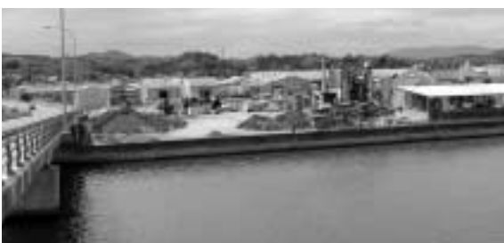
南周防大橋からみた米出工業団地
