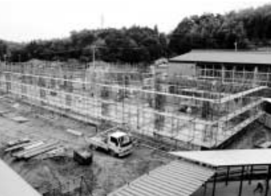
改築中の東田布施小学校
