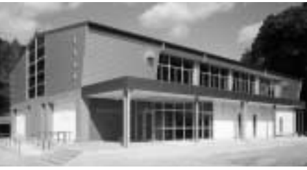
1月に完成した 田布施東小学校屋内運動場
