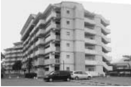
町営波野団地南住宅
