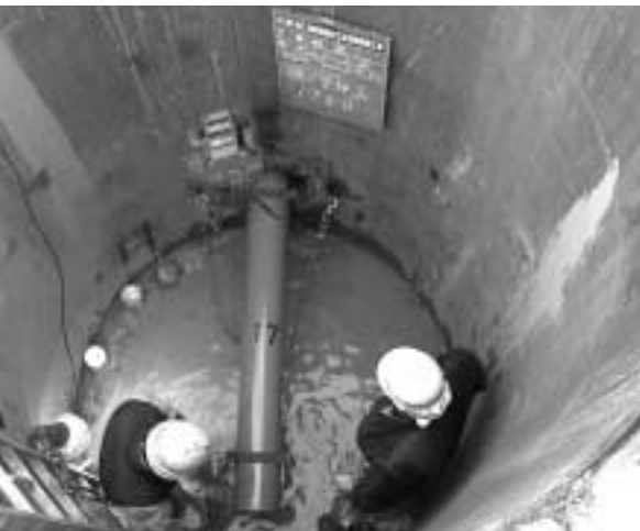
麻郷高塔地区下水道工事
