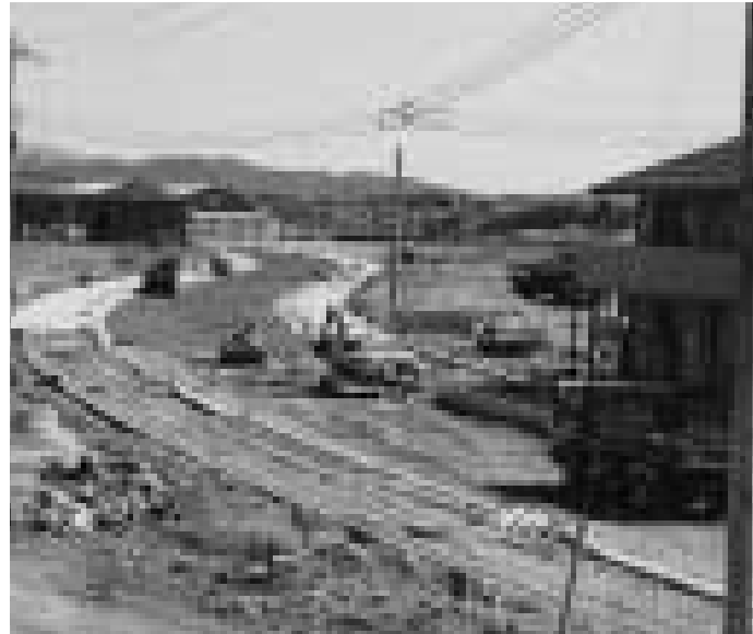
中央南土地区画整理の工事
