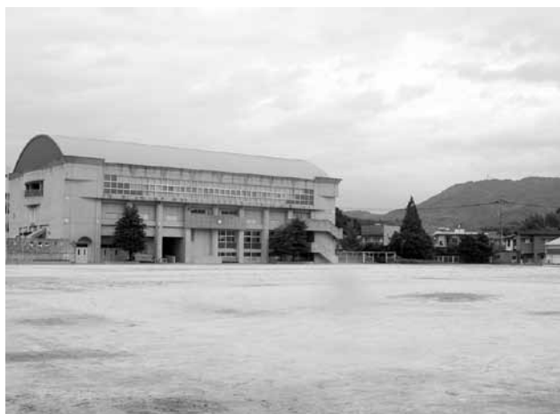
貯留施設設置予定地 (田布施中学校)
