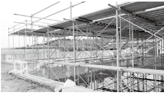
工事が進むスポーツセンタープール
