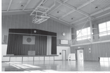
非構造部材が耐震化された体育館(城南小)
