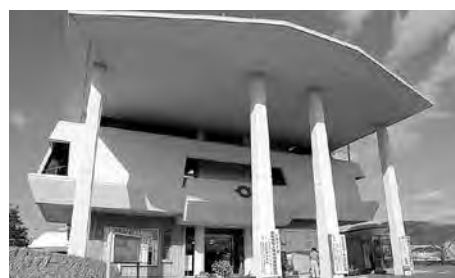
耐震性の確保が急がれる役場本庁舎
