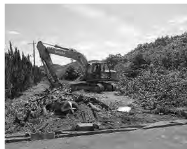
オラレ予定地では工事に着工
