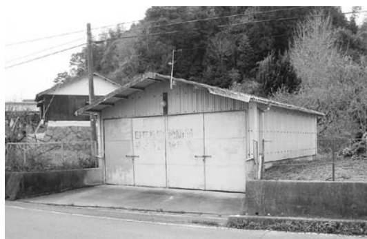
移転する第3分団の消防機庫
