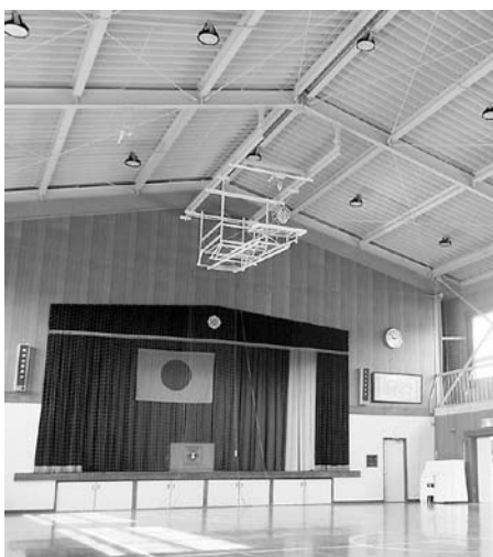
非構造部材が耐震化された体育館(城南小)
