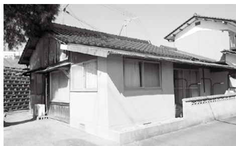
入居が望めそうにない空家
