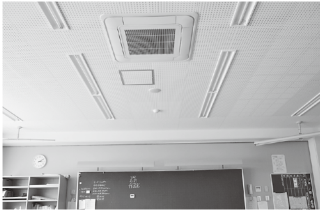
平生小改築教室 エアコン設置
