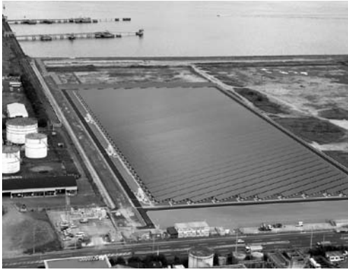
福山太陽光発電所① (中国電力提供)
