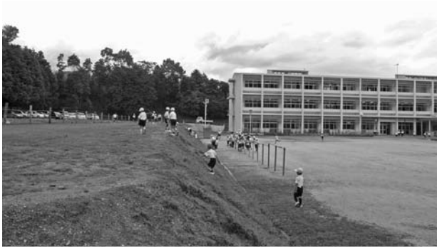
工事予定の麻郷小学校グラウンド
