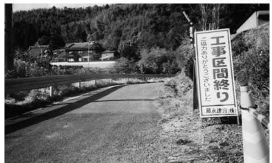
県道周東田布施線 改良工事現場(東畑)
